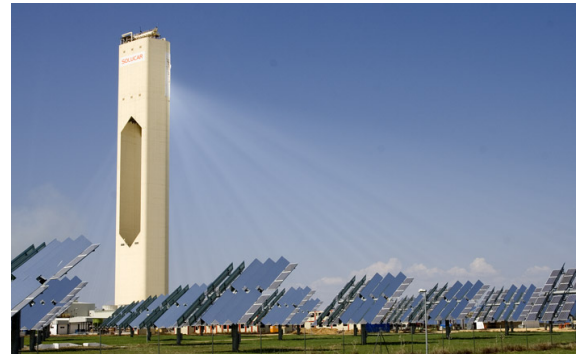
Solarturmkraftwerk PS10 in Spanien.
